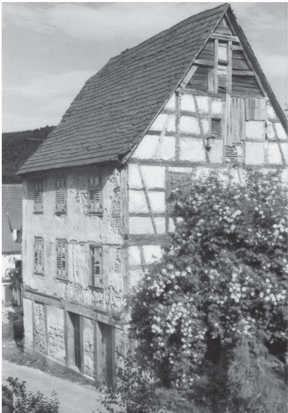
Haus Nr. 91 in der Burggasse vor dem Abriss 1976. Foto: Hans-Josef Ruggaber
